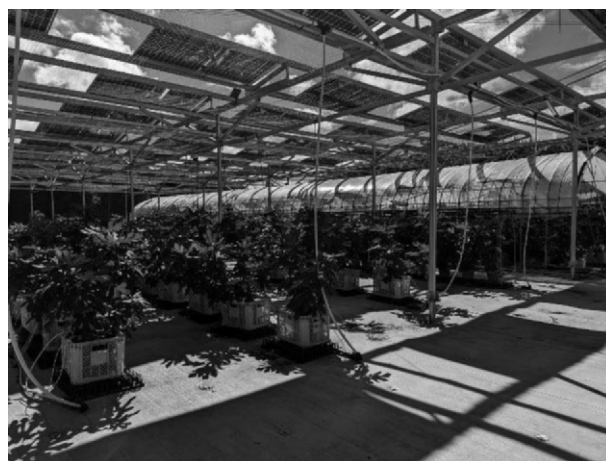
図1 遊休農地を再生利用した営農型太陽光発電設備
