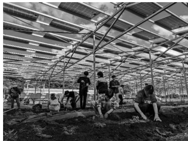
図7 千葉大学園芸学部の学生による営農型太陽光発電設備での農業生産実習
