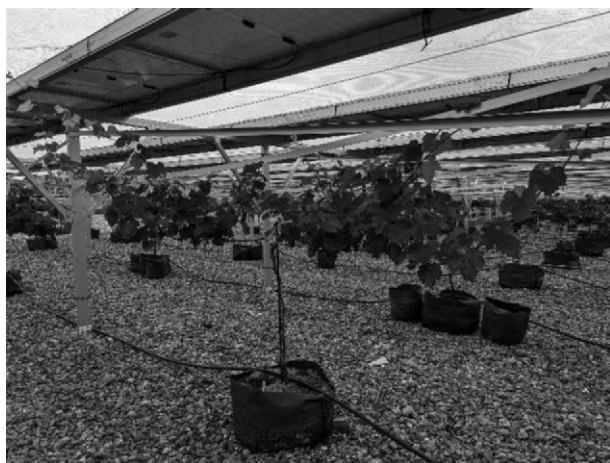
図5 営農型太陽光発電設備を利用しブドウの支柱並びに雨よけとしている事例
