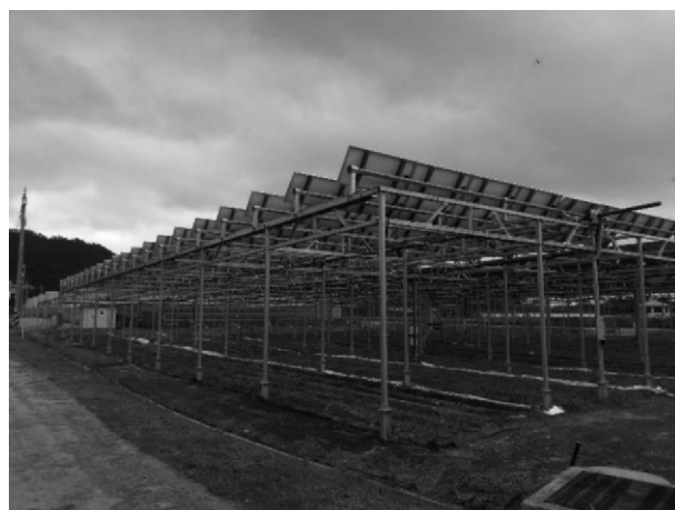
図11 韓国の農業試験場に設置された営農型太陽光発電の実証設備
