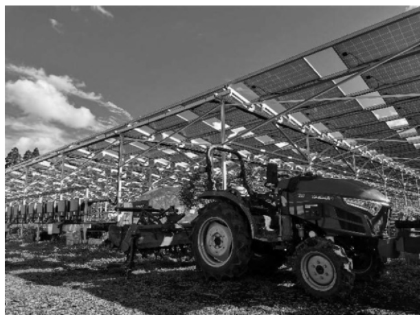
図2 農業生産並びに発電事業を一体で行っている営農型太陽光発電設備
